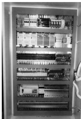
Рис. 3. Технологическая схема цеха и один из смонтированных шкафов микропроцессорного управления производством
