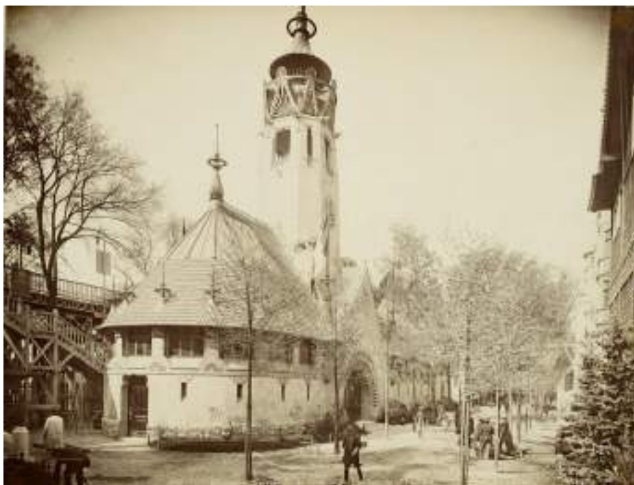
Ил. 6. Э. Сааринен, А. Линдгрен, Г. Гезеллиус. Здание павильона Финляндии на Всемирной выставке в Париже. 1900. Париж, Франция.
