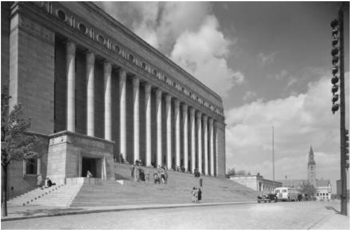
Ил. 13. Й. З. Сирен. Здание Парламента. Главный фасад. 1927–1931. Хельсинки, Финляндия.
