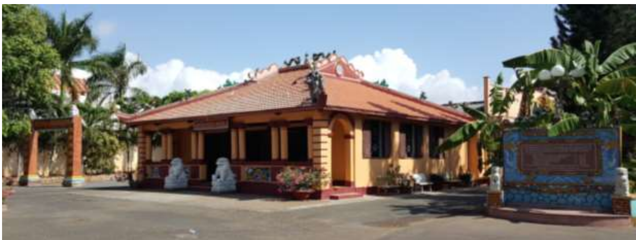
Рис. 29. Общинный дом района Тхангтам г. Вунгтау. Фото автора, март 2018.
